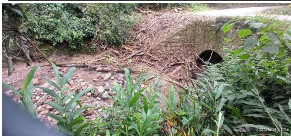
FIGURA N°02: SE OBSERVA MATERIAL COLMATADO EN EL BORDE DEL PUENTE DEL RIO ARROYO GRANDE
