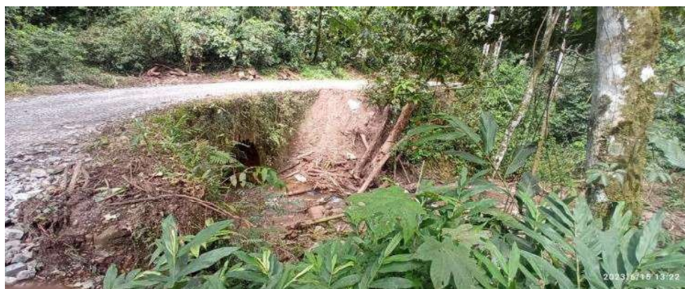
FIGURA N°03: SE OBSERVA DESPRENDIMIENTO DE TIERRA EN LA MARGEN IZQUIERDA DEL RIO ARROYO
